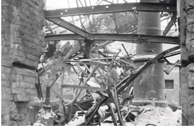
В одном из разрушенных зданий обсерватории. Б. Кудояров, 1942–1943 гг.
